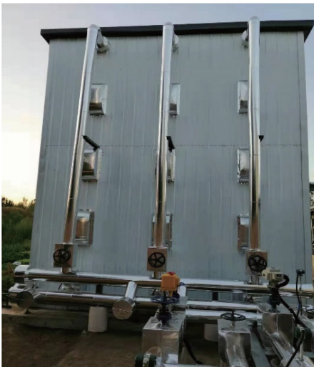
(b) 混凝土固体储热器实物
